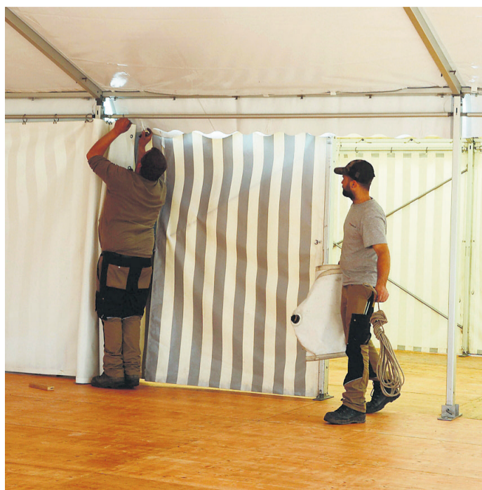
Noch eine letzte Plane befestigen, dann kann mit dem Einrichten begonnen werden.
